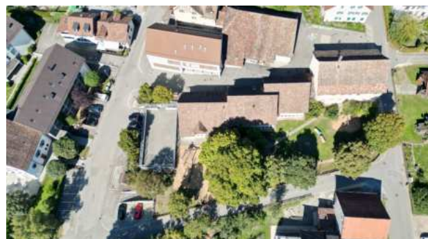
Abb. 25: Areal Trotte und Schulhaus (inexo)
